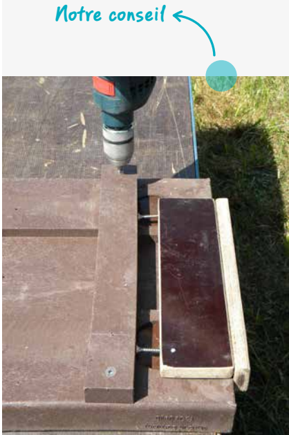
Montage de baguettes antidérapantes. Notre conseil : ave une jauge ajustable le montage devient rapide et exact
