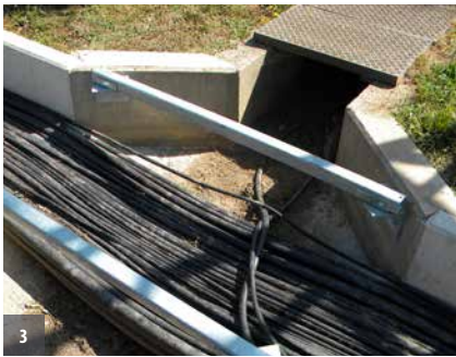
Pose de la baguette en métal dans les angles
